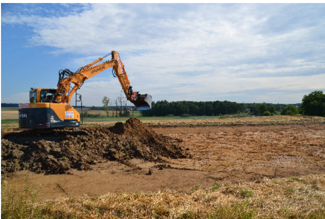
Der erste Bagger auf dem Grundstück! Foto Uwe Stelzer
